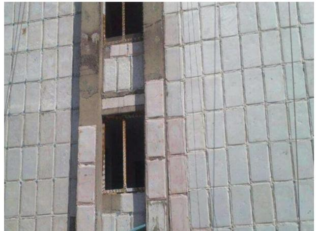
以芯材和吸气剂为填充材料，使用复合阻气膜作为包裹材料，经抽真空、封装等工艺制成的建筑保温用板状材料，简称VIP板，燃烧性能为A级。
